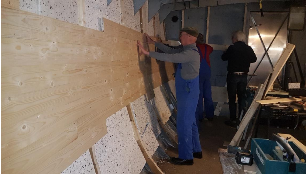
Foto: Aanbrengen wandbetimmering bakboordzijde
