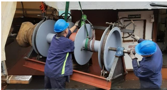
Afb: aan boord hijsen van de winch
