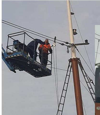
Aanbrengen van toplicht
